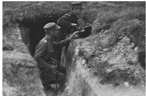
5 pav. Leitenantas ir jaunesnysis puskarininkis, pasiruošę sužadinti sprogdinimą su 1-20 arba 1-30 sprogdinimo mašinėle. 1930–1935 m. ( Autoriaus kolekcija )
