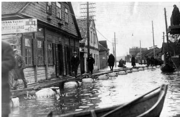
1 pav. 1-ojo inžinerijos bataliono įrengtas plūdinis lieptas potvynio metu. 1934 m. Kaunas (Autoriaus kolekcija)
