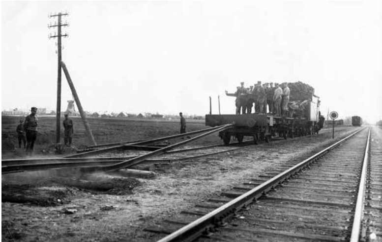
10 pav. Geležinkelio ardymas naudojant „kilpą“. 1931 m. Radviliškis ( Autoriaus kolekcija )
