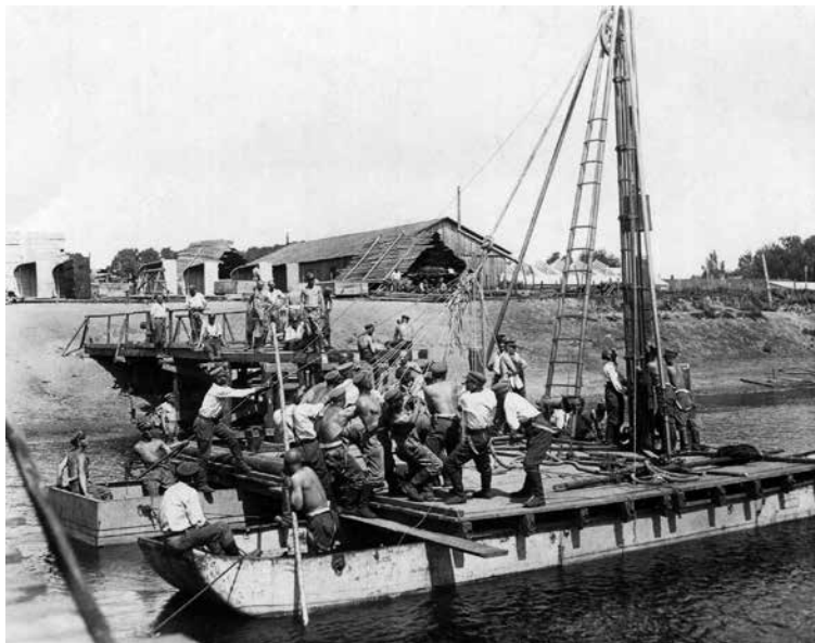
12 pav. 1-ojo inžinerijos bataliono Andersono mechaninė poliakalė, pastatyta ant pontoninio kelto. 1932 m. liepos mėn.
