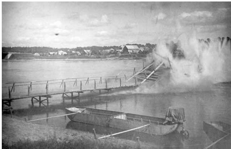
17 pav. 1-ojo inžinerijos bataliono įrengtas ir susprogdintas polinis tiltas. Šalia tilto pritvirtinti du puspontoniai su motoriniais varikliais išorėje. 1935–1940 m. (Autoriaus kolekcija)
