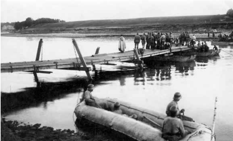
11 pav. Lauko pratybų metu inžinieriai įrengia pontoninį tiltą, kariai guminėje valtyje užtikrina saugą. 1931 m. Gaižiūnai ( Autoriaus kolekcija )
