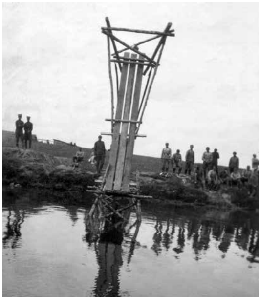
8 pav. Statomas Beseler tipo lieptas pėstininkams persikelti. 1930–1935 m. (Autoriaus kolekcija)
