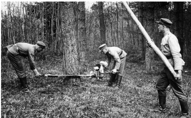
13 pav. Vokiškas motorinis grandininis pjūklas Dolmar Maschinen Gesellschaft m.b.H su EII tipo 18 AG varikliu (Autoriaus kolekcija)
