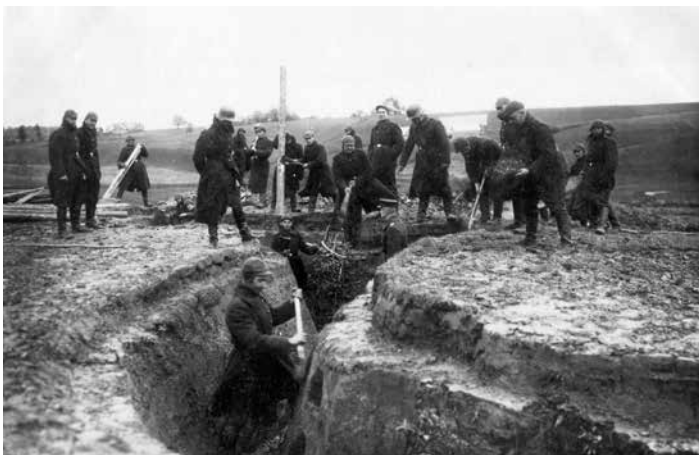
3 pav. Kariai įrengia apkasus su sutvirtintomis susisiekimo eigomis. 1930–1940 m. ( Autoriaus kolekcija )
