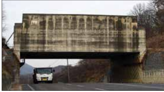
Konstrukcija, skirta keliui blokuoti (nuleidžiama sprogdinant)
