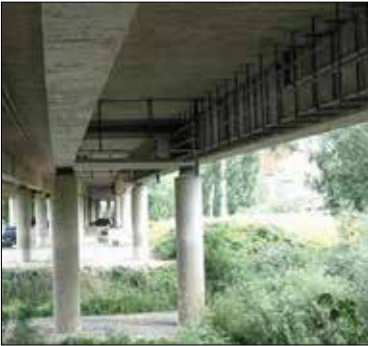
Aptarnavimo takai po tilto konstrukcija
