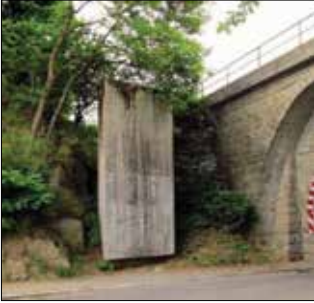
Konstrukcija, skirta keliui blokuoti (nuverčiama sprogdinant)
